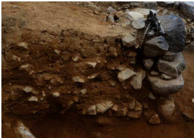
2 石垣西側断ち割り状況（北西から）
