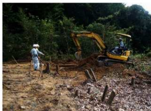
重機による表土除去
