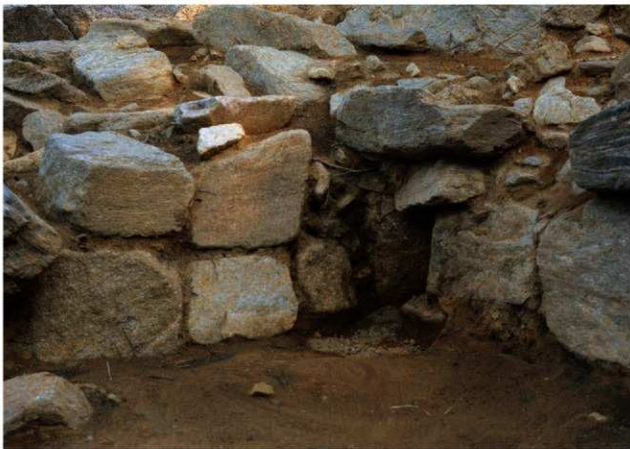
1 石段1と石垣の結合状況（南西から）
