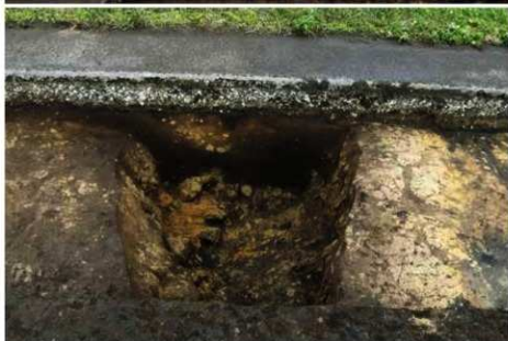
トレンチ 12 溝完掘 (北西から)
