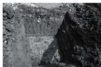
第59図 トレンチ掘削状況
