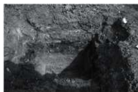
第39図 トレンチ掘削状況
