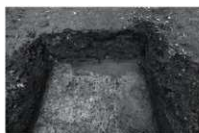
第55図 トレンチ掘削状況
