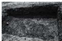
第51図 トレンチ掘削状況
