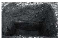
第49図 トレンチ掘削状況
