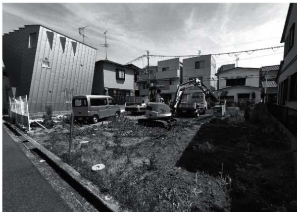
(1) 調査前（北西から）
