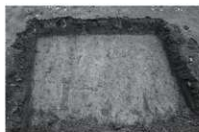
第76図 トレンチ掘削状況
