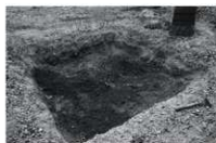
第17図 トレンチ掘削状況
