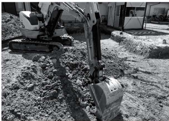
(2) 重機掘削（東から）
