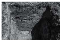
第98図 トレンチ掘削状況
