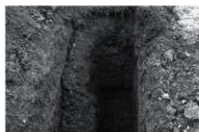
第152図 トレンチ掘削状況
