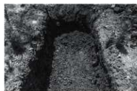
第74図 トレンチ掘削状況
