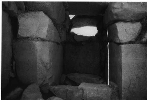
(2) 8号墳玄門状況(奥壁より)
