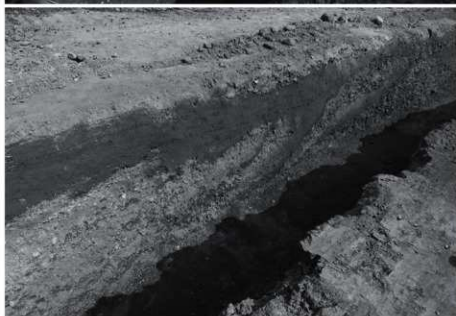
C 地区 トレンチ中央部 (南東から)
