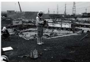
遺構図化作業
