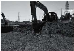
機械掘削状況
