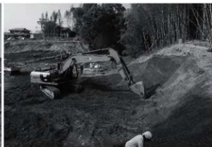
機械掘削状況
