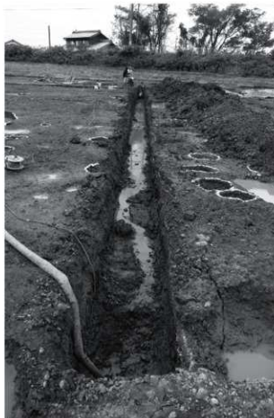
B地区 トレンチ1全景(東から)
