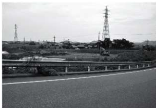
調査前の状況
