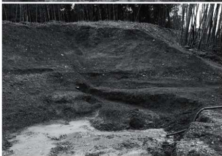
C地区東側堰堤断面（北西から）
