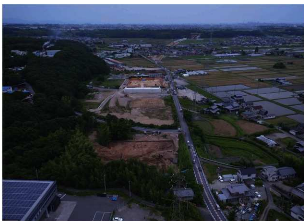
調査区上空から印南野台地方面（南）を望む
