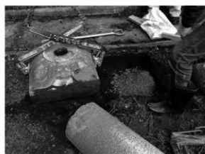
②-2 灯籠基礎地盤安定作業
