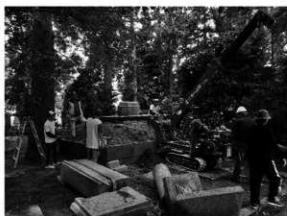
④-1 8代墓復旧作業 (東から) (6月)
