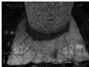
①-2 接合部モルタル補強
