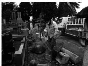
②-1 参道寄進灯籠復旧作業 (3月)
