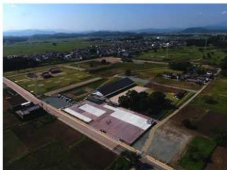
整備された下園東区面広場
