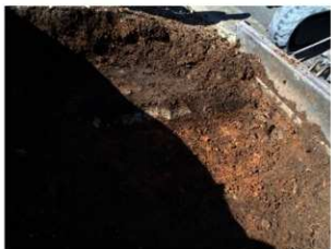
遺構掘削状況 (北から)
