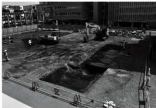
B区 1面掘削状況(北西)
