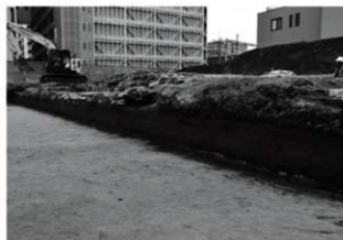
A区 中央の土層断面SPA-A“(北東)
