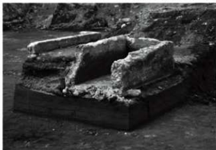
B区 5号(左)・6号(右)コンクリート遺構(南西)
