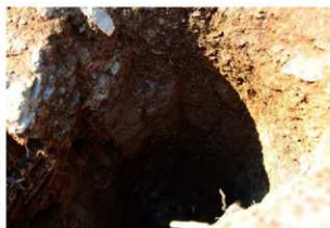
2 P 岩盤掘削痕
