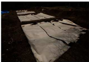
養生シート被覆
