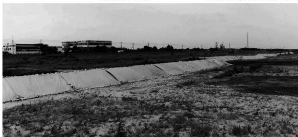
越冬養生状況 E→W
