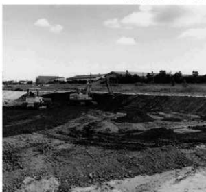
重機による法面施行状況 N→S
