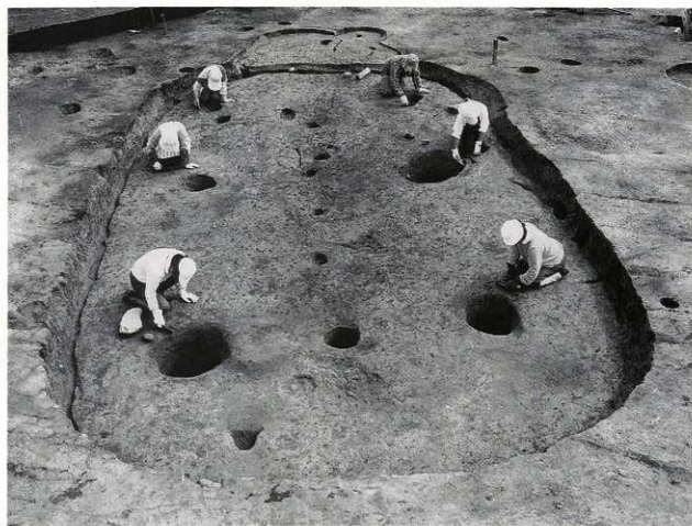
2 H-4 全景 (北西から)
