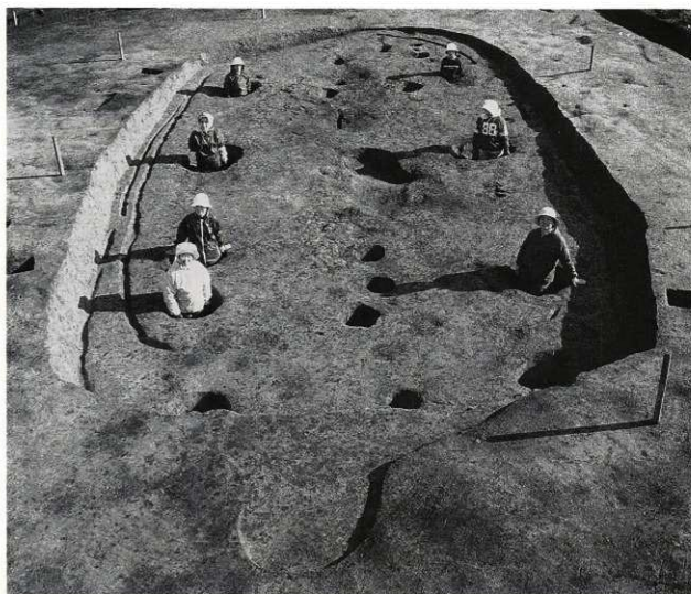
1 H-3 全景 (北西から)
