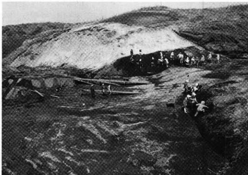
1 火山灰除去全景（南東から）
