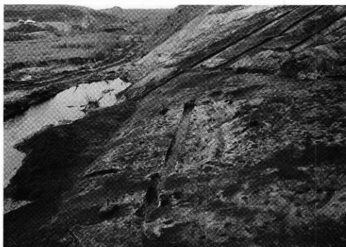
2 H-1・2完掘状況と柱穴群（北東から）
