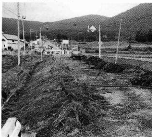
3. アスファルト除去後 (S→)
