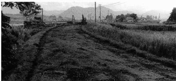
2. A地区アスファルト除去後 (NE→)
