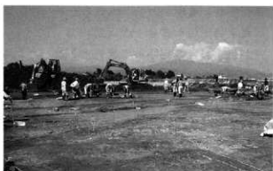
A区作業状況（東から）
