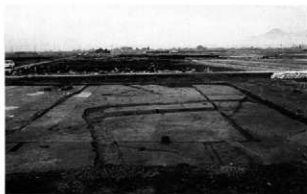
A区完掘状況（南から）
