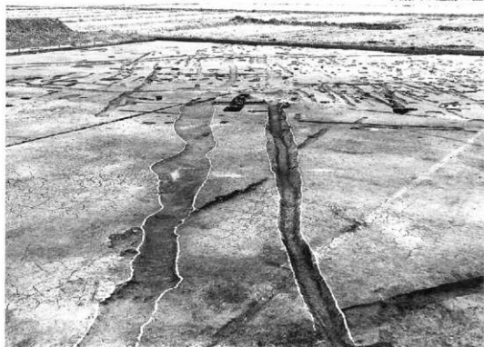
S F 120道路跡 (南東から)
