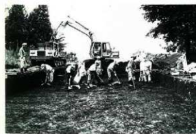
ジョレンによる面整理（南東から）
