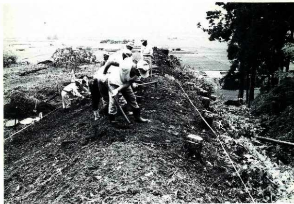
土塁調査状況 (南東から)
