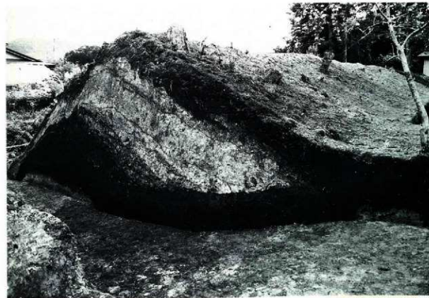
土塁土層断面 (西から)
