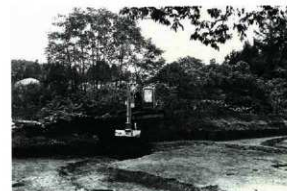
埋め戻し作業状況 (東から)
