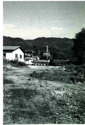
重機による表土除去作業（北西から）
