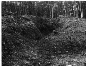
SD2現状(東から)
