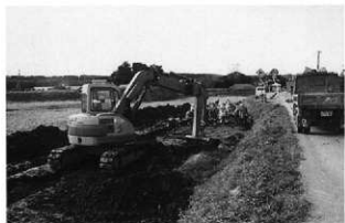
重機械表土除去
