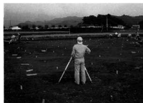
グリッド杭打風景 (北西から)
