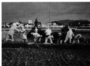
重機租堀・排水風景 (南から)
