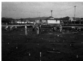
遺構確認風景 (南西から)
