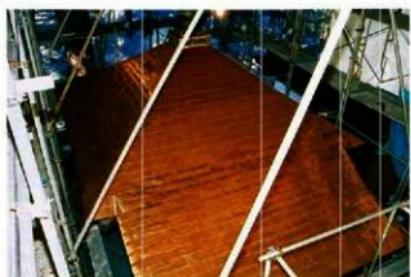
4-10 b 屋根銅板葺施工状況
