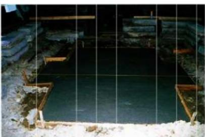
4-7 e 基礎コンクリート打設状況
