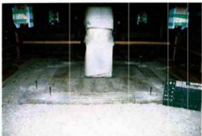
4-8 b 基礎アンカーボルト取付状況
