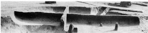
4 H-508セクション (SW→NE)
