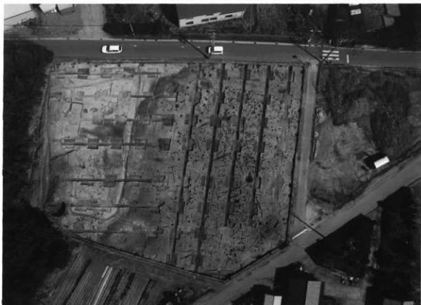
西側道路 A4 地区 全景（上空より）
