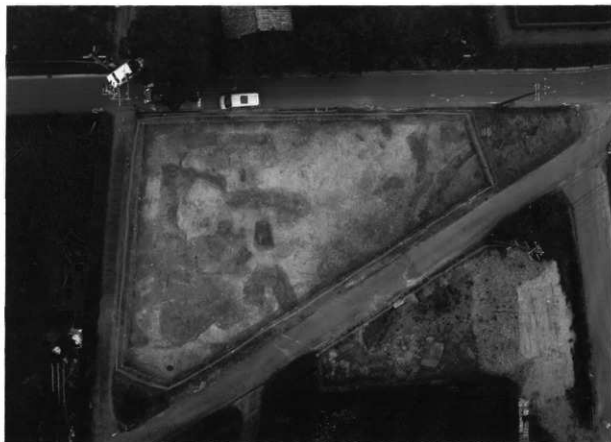
西側道路 A2 地区 全景（上空より）
