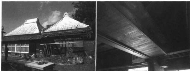
写真5-1 釜屋建民家と谷樋（豊橋市石巻本町広福・鈴木邸 2010.01.30撮影）
