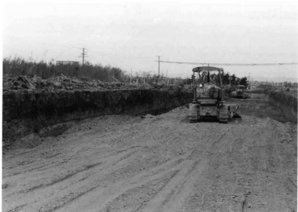
1、送水管施設移設工事の状況（西から）
