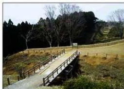
再整備前の二ノ丸西堀橋
