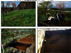
写真 調査状況
