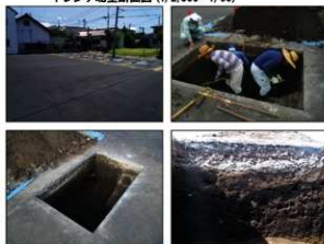
写真 調査状況
