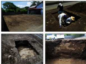
写真 調査状況
