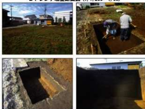
写真 調査状況
