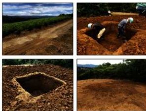
写真 調査状況
