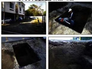
写真 調査状況
