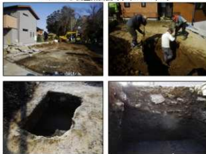
写真 調査状況
