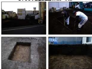
写真 調査状況
