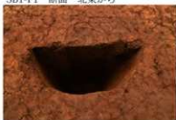
SB1-P4 断面 南西から
