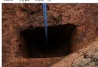
SB1-P1 断面 北東から
