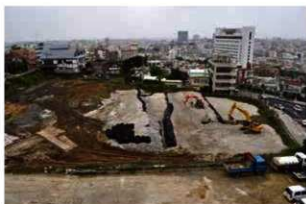
2 I区 保護砂埋戻し状況(東から)
