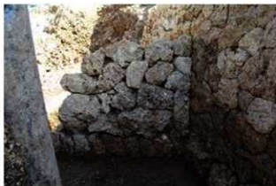
Ⅲ区 SA3002 立面(西から)
