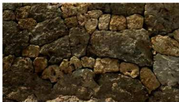
IV区 SA4001 近景(北から)
