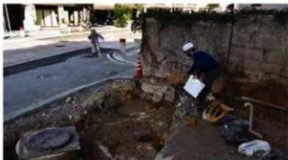
正門新設工事箇所 作業状況(南西から)
