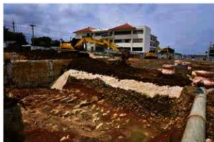
5 SF5001 埋戻し状況(北東から)
