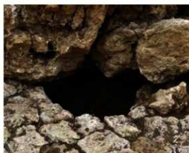
I 区 SS24 排水用の穴(南から)
