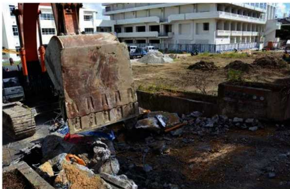
1 スロープ掘削作業状況(南西から)
