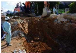
4 駐輪場予定地 掘削作業状況(西から)
