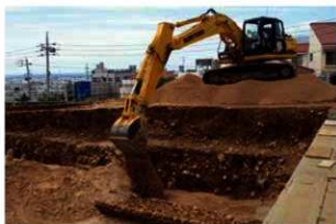
3 SA4003 保護砂埋戻し状況(南東から)
