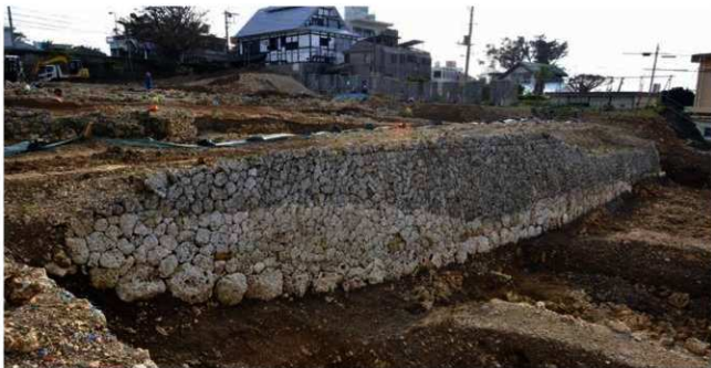
I 区 SA1 立面(北東から)
