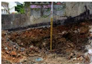
2 スロープ堆積状況(西から)
