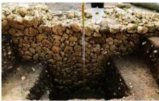
V区 SA5003 立面(西から)
