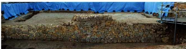
IV区 SA4001 立面(北から)
