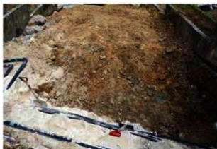
3 スロープ掘削後状況(南から)
