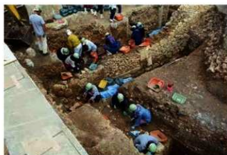
Ⅲ区 SA3001 作業状況(南西から)
