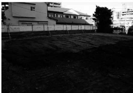
3. 調査終了 埋戻し完了状況 (南西から)
