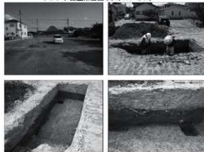
写真 調査状況
