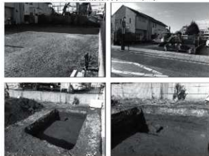
写真 調査状況
