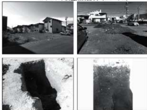
写真 調査状況
