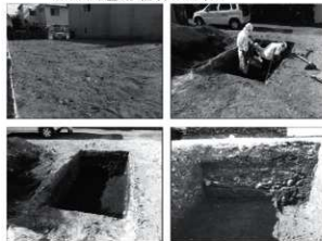
写真 調査状況
