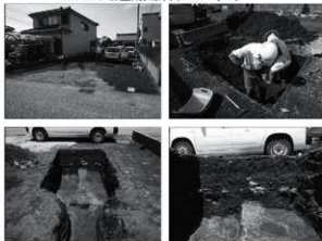
写真 調査状況
