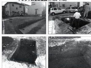
写真 調査状況
