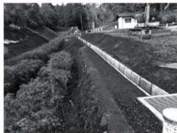
排水溝新設整備（三ノ丸西堀）
