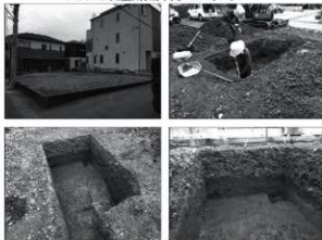
写真 調査状況
