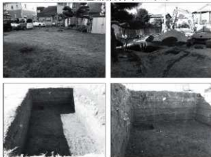
写真 調査状況
