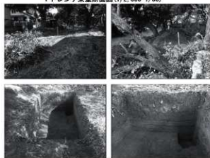
写真 調査状況
