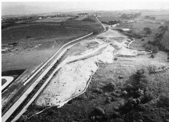
1 遺跡の空中写真（東から）
