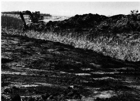
1 表土除去作業 (南東から)
