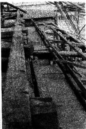
40 面番所北面廊下及床ノ間解体
