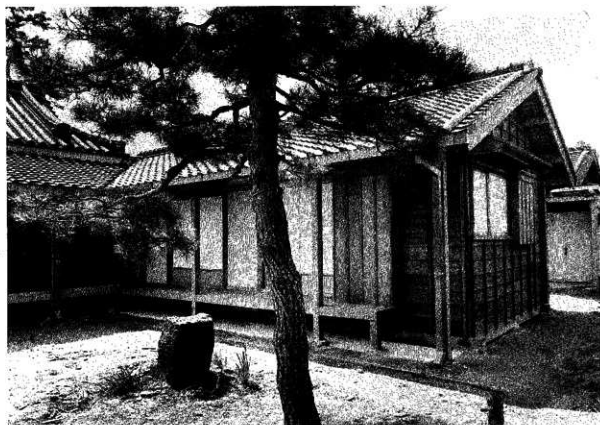
14 竣工 同心及下改勝手東北面
