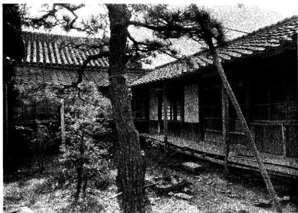
31 修理前 面審所北面廊下及同心及下改勝手東面
