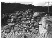
写真20 石室解体右側壁
