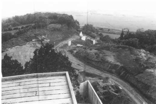
挿図第27 E区の調査状況
