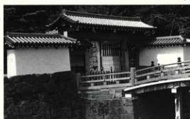
写真-16 門・橋の復原例(和歌山城一の橋門)
