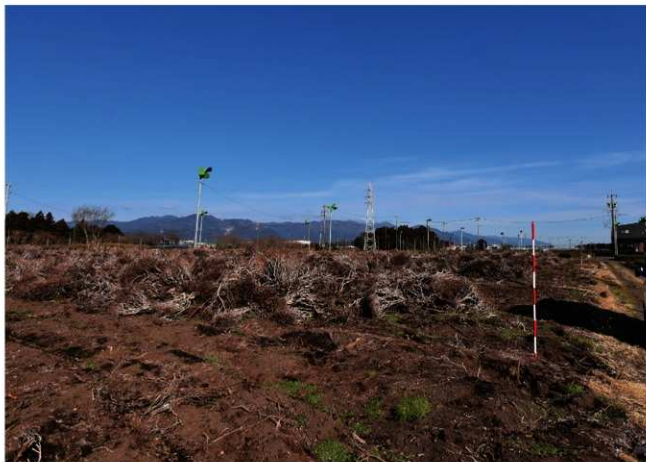
調査前風景（南東から）
