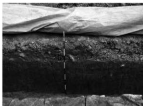
写真 29 2006-Ⅲ区北半 E13-m23 調査区東壁断面土層 (西から)
