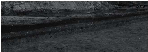
1. 1区 北壁 (Y=-41,385~-41,400 付近) 断面 (南西から)
