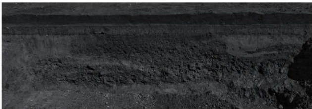
3. 6区 北壁 (X=-172.860 付近) 断面 (南西から)
