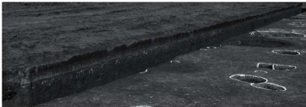
2. 1区 北壁 (Y=-41,305~-41,320 付近) 断面 (南西から)
