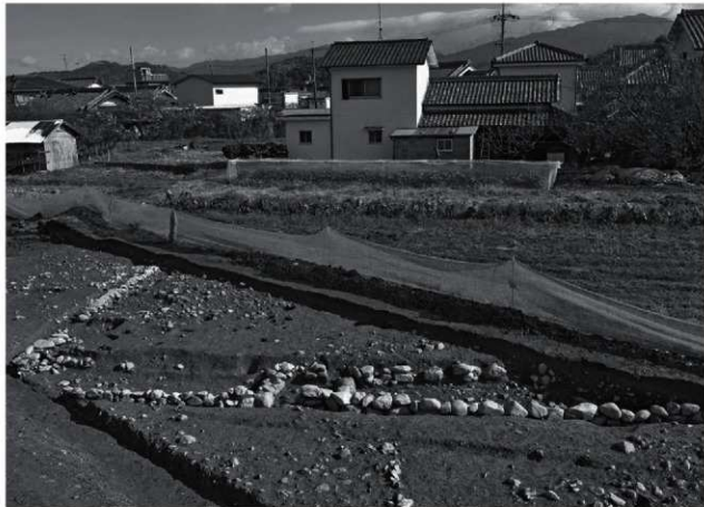
1. 4区 810・812 石積み基礎 石積み全景（西から）
