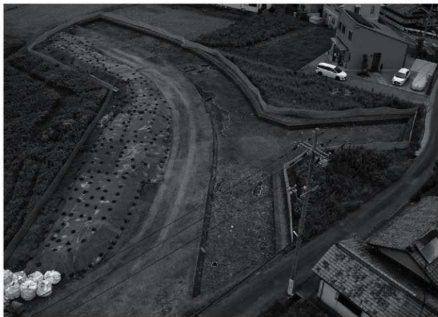
1. 3-1区 全景 (南西から)
