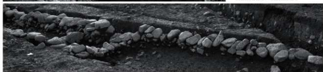
3. 4区 810石積み基礎 石積み背面 (東から)
