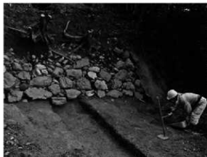
Fig.41 二俣城跡西の丸Ⅰ作業風景
