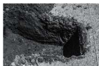
第111図 トレンチ掘削状況
