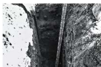
第134図 トレンチ掘削状況
