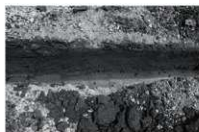
第115図 トレンチ掘削状況
