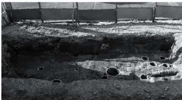
(5) 第1トレンチ全景（掘削後）
