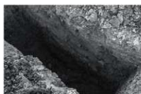
第185図 トレンチ掘削状況
