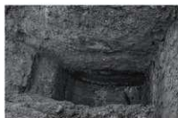
第171図 トレンチ掘削状況
