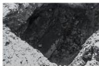
第187図 トレンチ掘削状況
