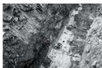
第143図 トレンチ掘削状況
