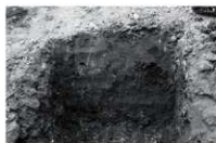
第189図 トレンチ掘削状況
