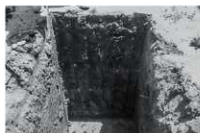
第101図 トレンチ掘削状況
