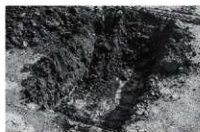
第177図 トレンチ掘削状況
