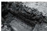
第117図 トレンチ掘削状況
