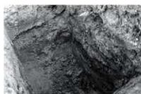
第179図 トレンチ掘削状況
