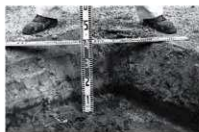
第193図 トレンチ掘削状況
