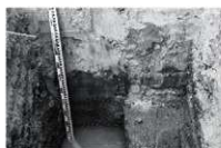
第149図 トレンチ掘削状況
