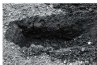
第 91 図 トレンチ掘削状況
