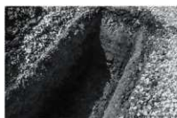
第 75 図 トレンチ掘削状況
