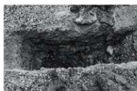
第167図 トレンチ掘削状況
