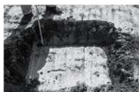
第 105 図 トレンチ掘削状況
