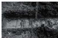
第147図 トレンチ掘削状況
