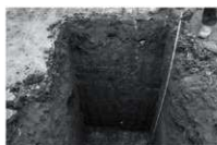
第 93 図 トレンチ掘削状況
