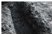
第181図 トレンチ掘削状況
