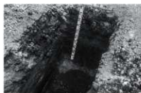
第 71 図 トレンチ掘削状況
