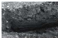
第183図 トレンチ掘削状況
