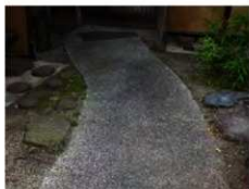
[写真 4-10] 飛石から舗装への改修 [南庭 (青龍庭)]
