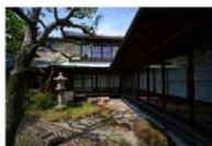
〔写真 3-62〕 主屋南北棟
