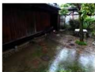
〔写真 4-2〕豪雨時の排水不良（中庭） 令和2年（2020年）7月14日
