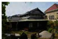
〔写真 3-67〕 離れ全景 (北から)
