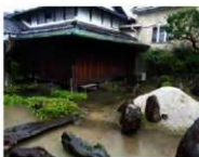
〔写真 4-6〕豪雨時の排水不良 〔南庭（青龍庭）〕
