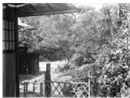
〔写真 2-10〕 庭園改修前
