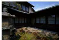
〔写真 3-61〕 主屋東西棟
