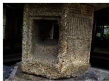
〔写真 4-16〕石燈籠8 火袋の割れ（中庭）
