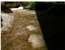
[写真 4-9] 飛石周辺の土砂堆積 [南庭 (青龍庭)]
