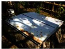
〔写真 4-17〕竹蓋から鉄蓋への変化（中庭）
