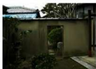
[写真 3-54] 中仕切扉
