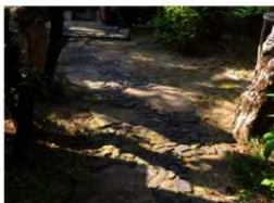
【写真 4-11】地被類の衰退（北東庭）
