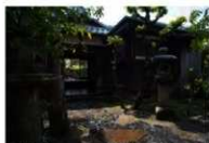
〔写真 3-59〕 本玄関アプローチ
