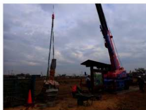
標柱移設状況
