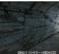
防空壕1 コンクリート型枠の痕跡
