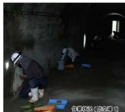
作業状況(防空壕1)
