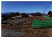
調査地全景【東より】
