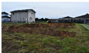
調査地全景【北西より】
