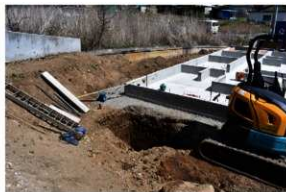
調査地全景【南西より】
