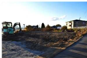
調査地全景【東より】
