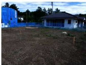
調査地全景【南東より】
