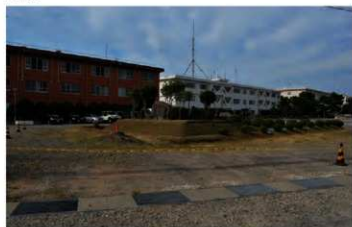
着手前状況（慰霊碑移転前）（南から）
