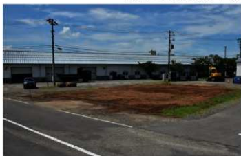
着手前状況（慰霊碑移転後）（北から）
