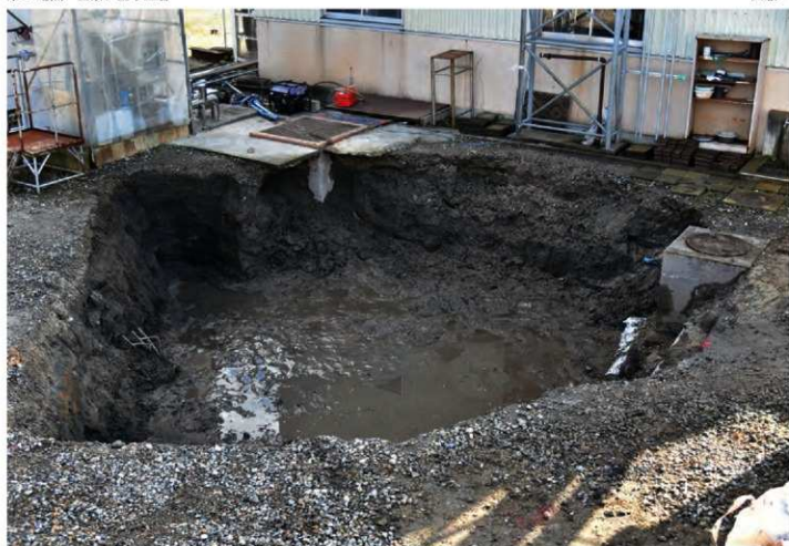
第32地点 全景・完掘状況（北西から）
