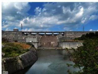
写真6.3. 下流から金武ダム堤体を望む
