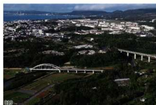
写真4.5. 宮城原地区遠景（東より）
