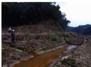
写真5.2. ショウイチ橋（正一橋）検出状況
