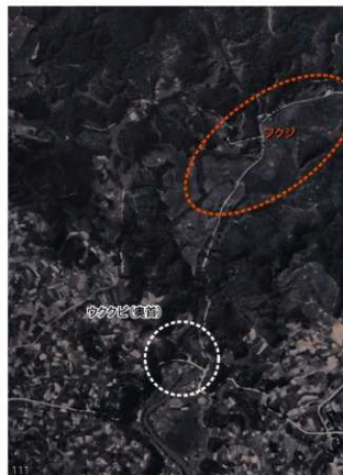
写真 5.1 億首川上流域鳥瞰（金武ダム建設前）
