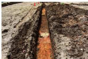
SB7 のプラン (Tr6 で検出)【東より】
